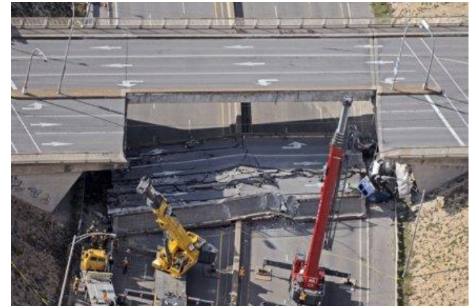
viaduc de la Concorde
